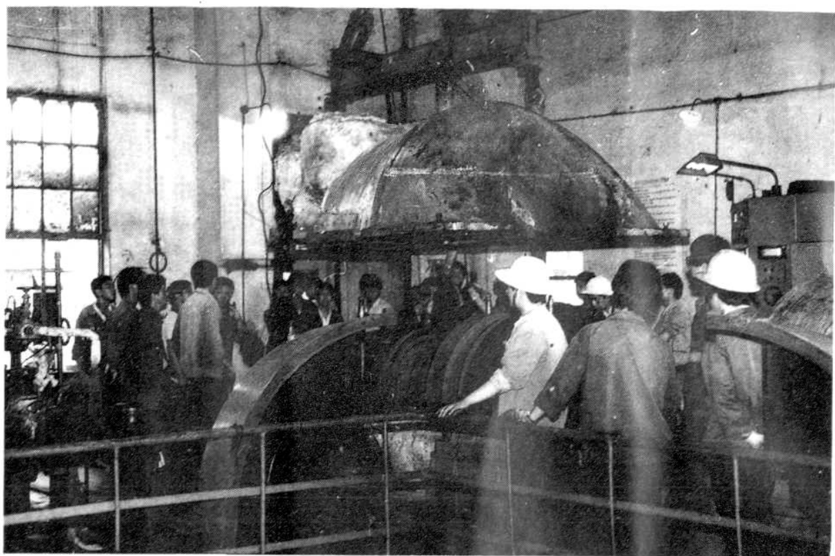
104号汽轮发电机组大检修
