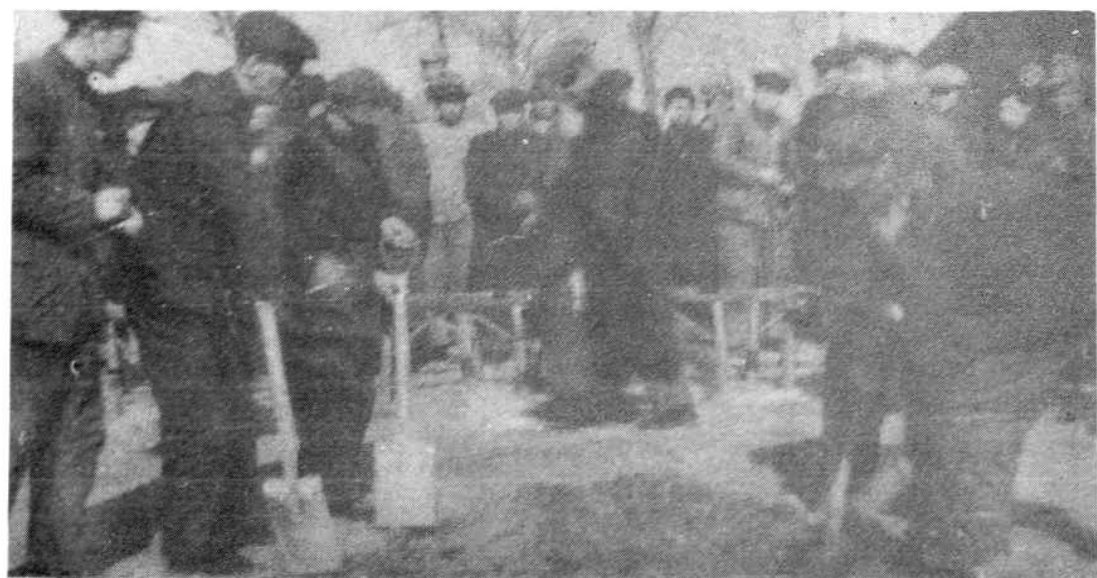
省、市部分领导为5000千瓦机组破土动工
