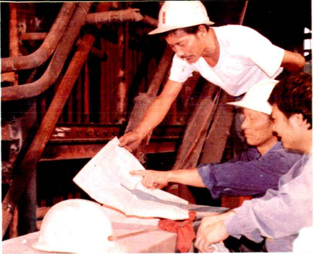
施工 鍋爐安裝隊在萬安糖廠
