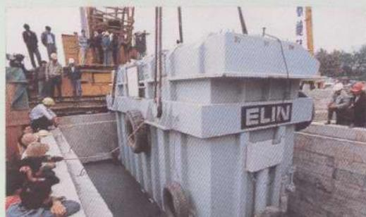
重达 160 吨的 240 兆伏·安变压器本体被吊入 14 米深处
