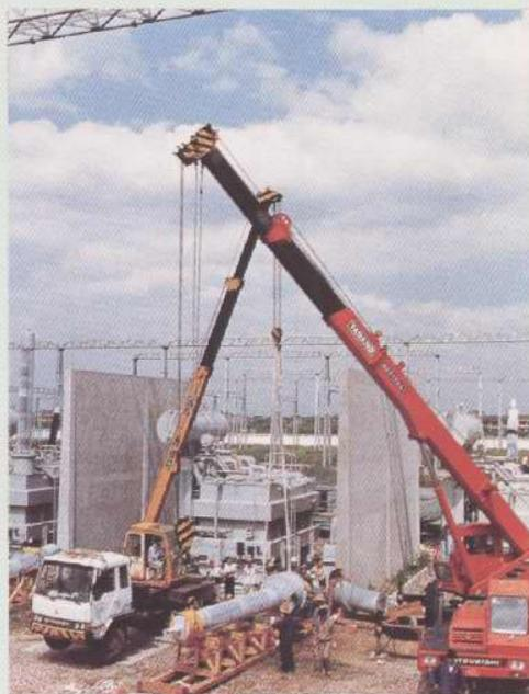
吊装变压器套管
