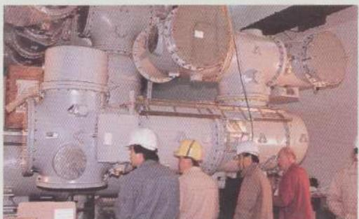
正在安装 GIS 装置中的 110 千伏 SF<sub>6</sub> 组合电器
