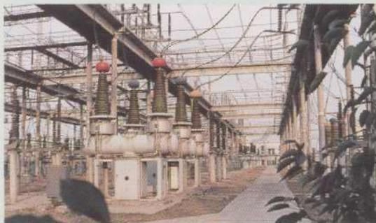
采用户外型 SF<sub>6</sub> 断路器的 220 千伏变电站——长春变电站
