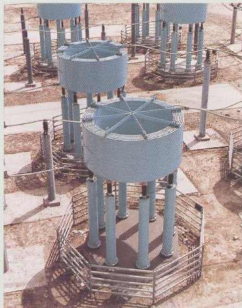
安装在杨高变电站内的两组90兆伏·安电抗器
