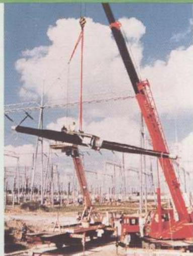
安装国内最长的±500千伏直流穿墙套管
