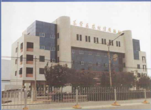
东营区农村信用联社办公大楼
