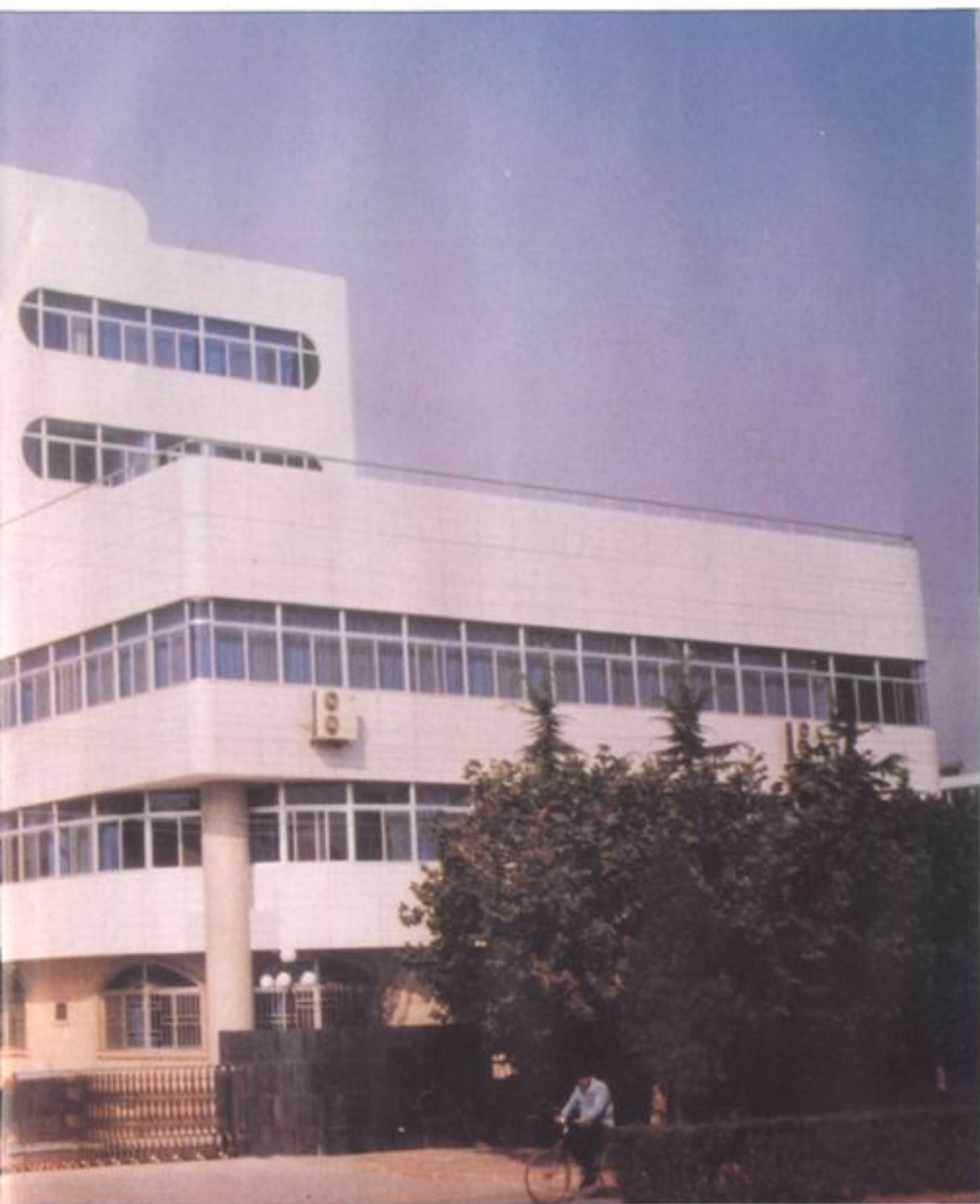
莱西市财政局机关办公楼
