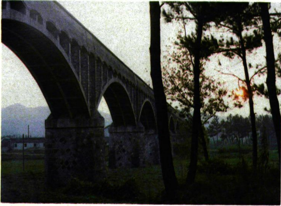
十六、城北引水工程，全长 16000 余米，通过渡槽可将巧溪水库的水引入幸福水库。
