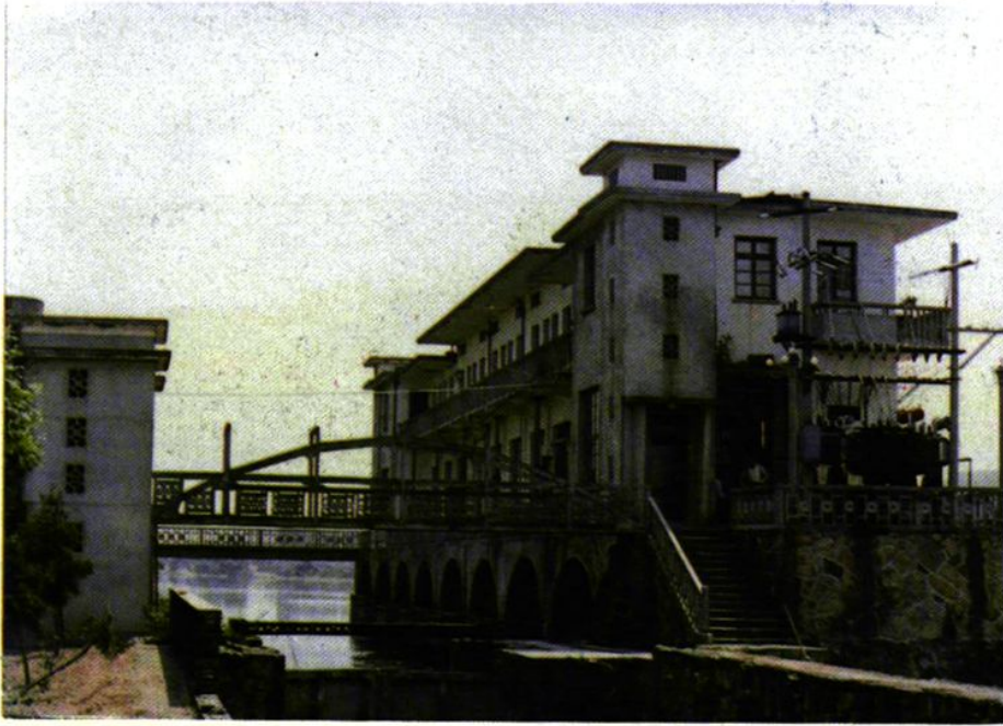
二十、塔下水轮泵站装机 700 千瓦，图为左岸电站厂房。
