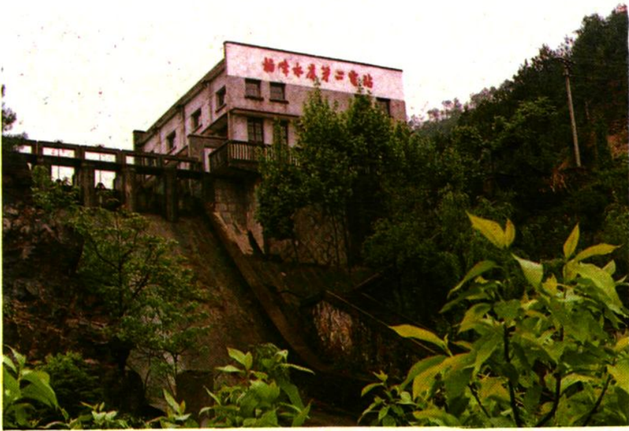
十二、柏峰水库位于佛堂区赤岸镇，1970年9月开工，1974年12月竣工，正常库容1945万立方米，灌溉面积3·26万亩。
