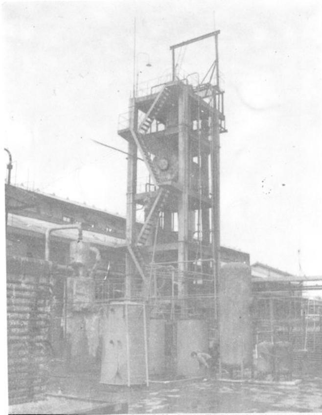
简阳红塔氮肥厂水-气平衡工程：稀氨水回收槽（红塔氮肥厂供稿）
