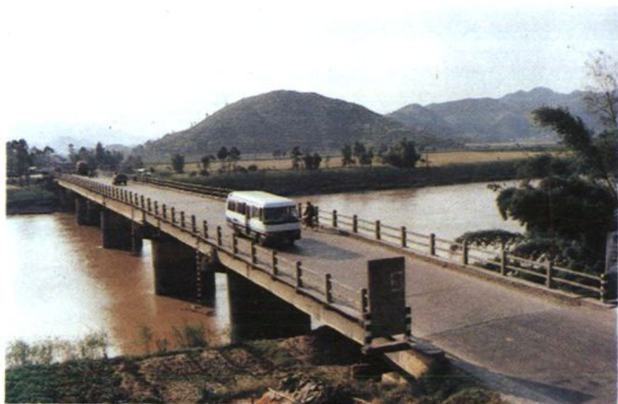
岱口公路大桥
