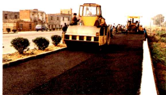
机械化作业铺筑沥青路面
