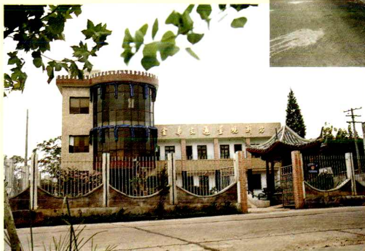
330国道金华十二里交通量观测站
