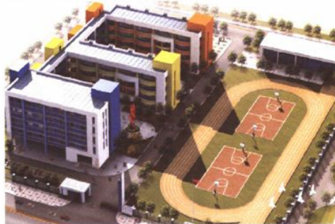
正在建设中的体育新城小学
