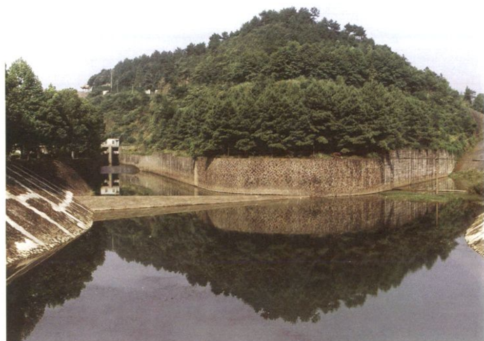
赋石水库泄洪洞、泄洪渠
