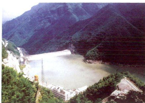
天荒坪抽水蓄能电站下水库全景
