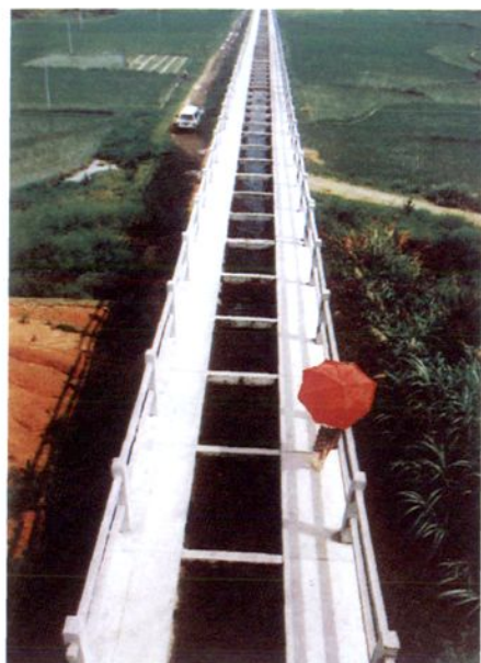
赋石渠道北山寺渡槽
