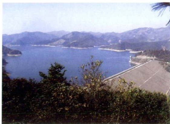
赋石水库全景
