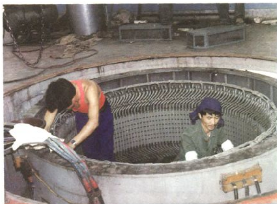
赋石电站机组大修
