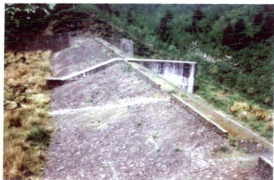
赋石水库非常溢洪道（自溃坝）
