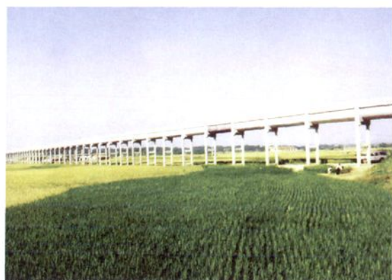
赋石渠道下北山寺渡槽
