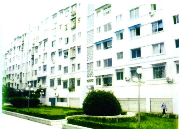
▲ 2001年建成的遂宁市局鸿雁花园小区职工宿舍
