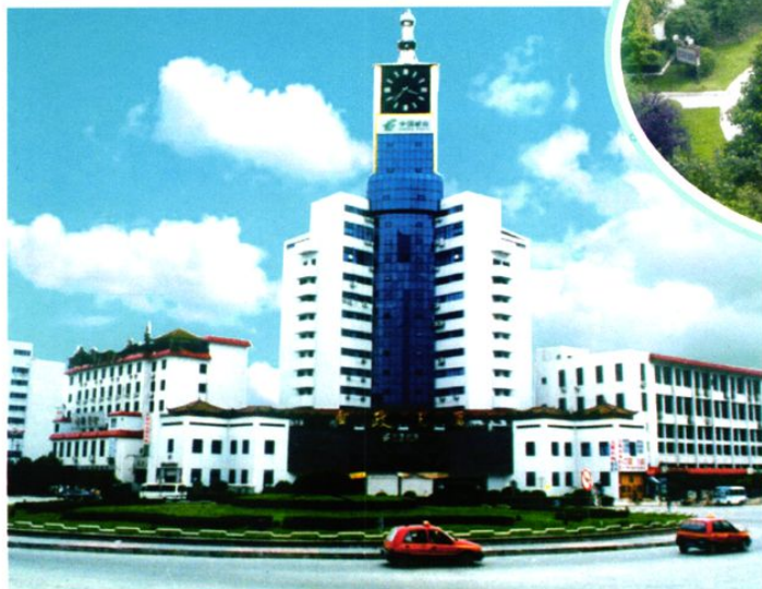
▲ 1997年1月竣工的遂宁邮政大厦
