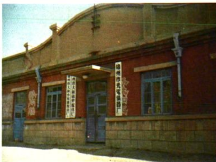
水泵密封件厂 锅炉配件厂 光电仪器厂
