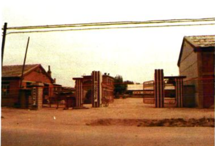
开关柜厂 气炉厂
