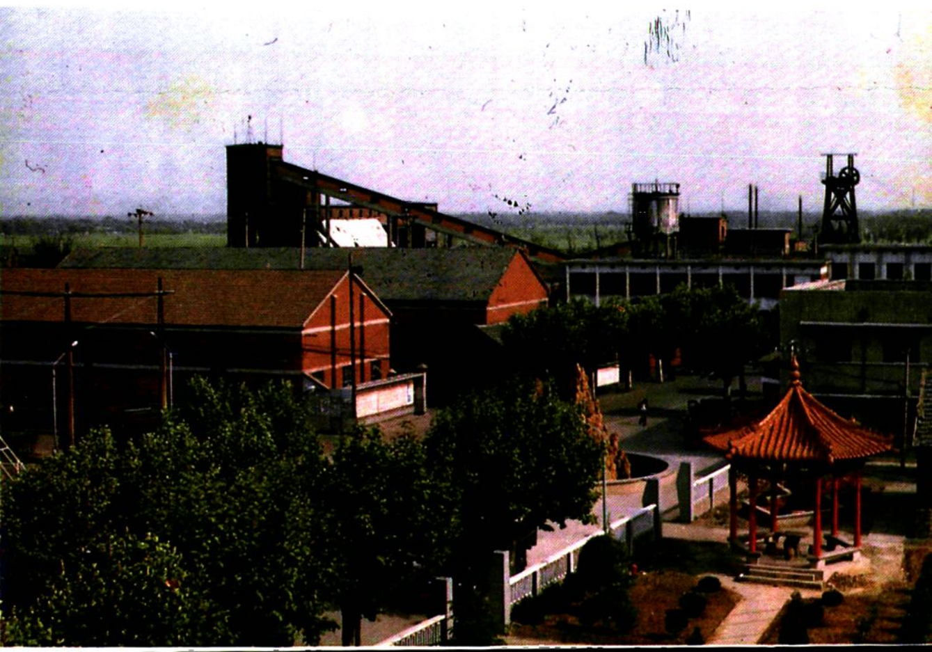
工业广场全景
