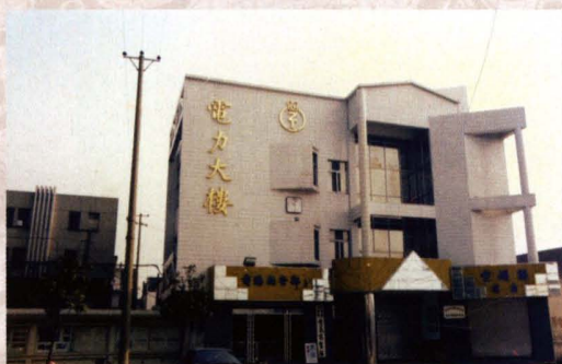
支塘电力管理站
