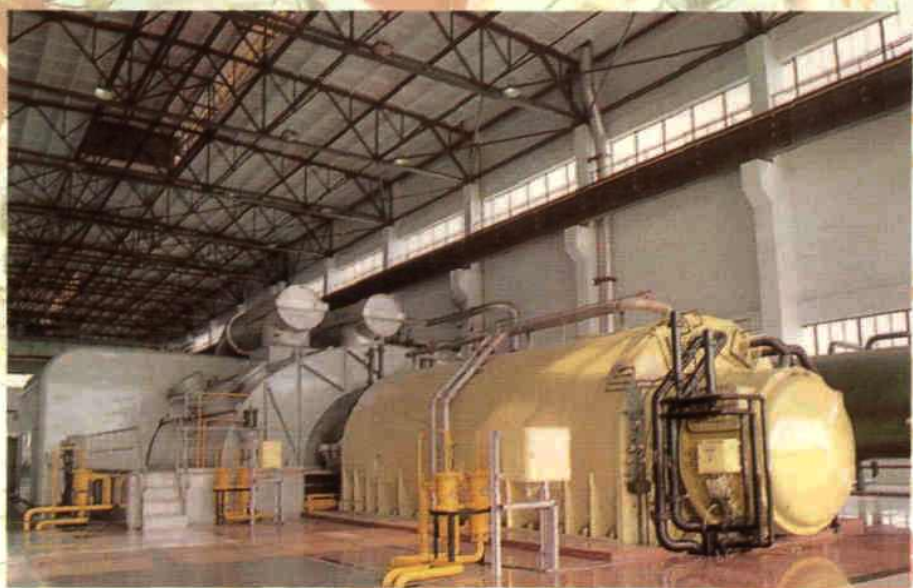
江油发电厂从法国引进的33万千瓦发电机组
