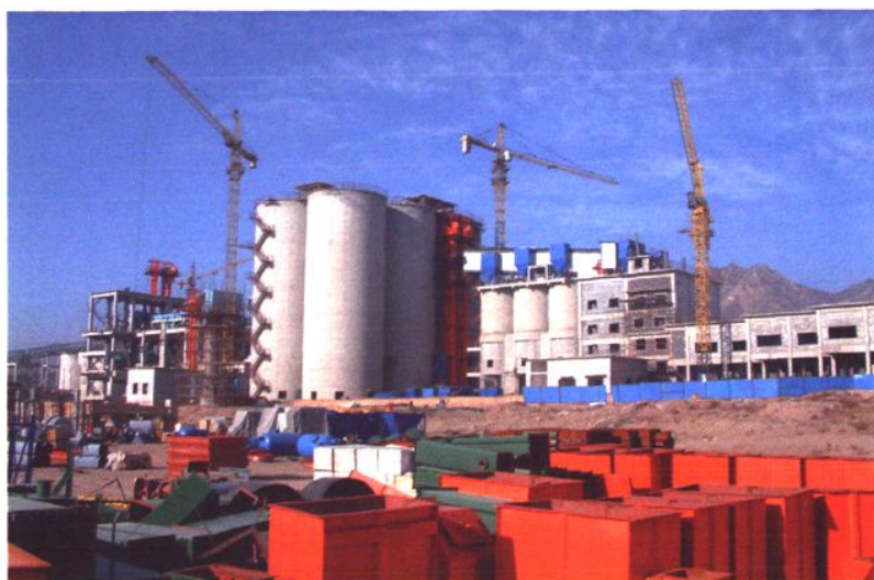
同煤水泥干法工程一角
