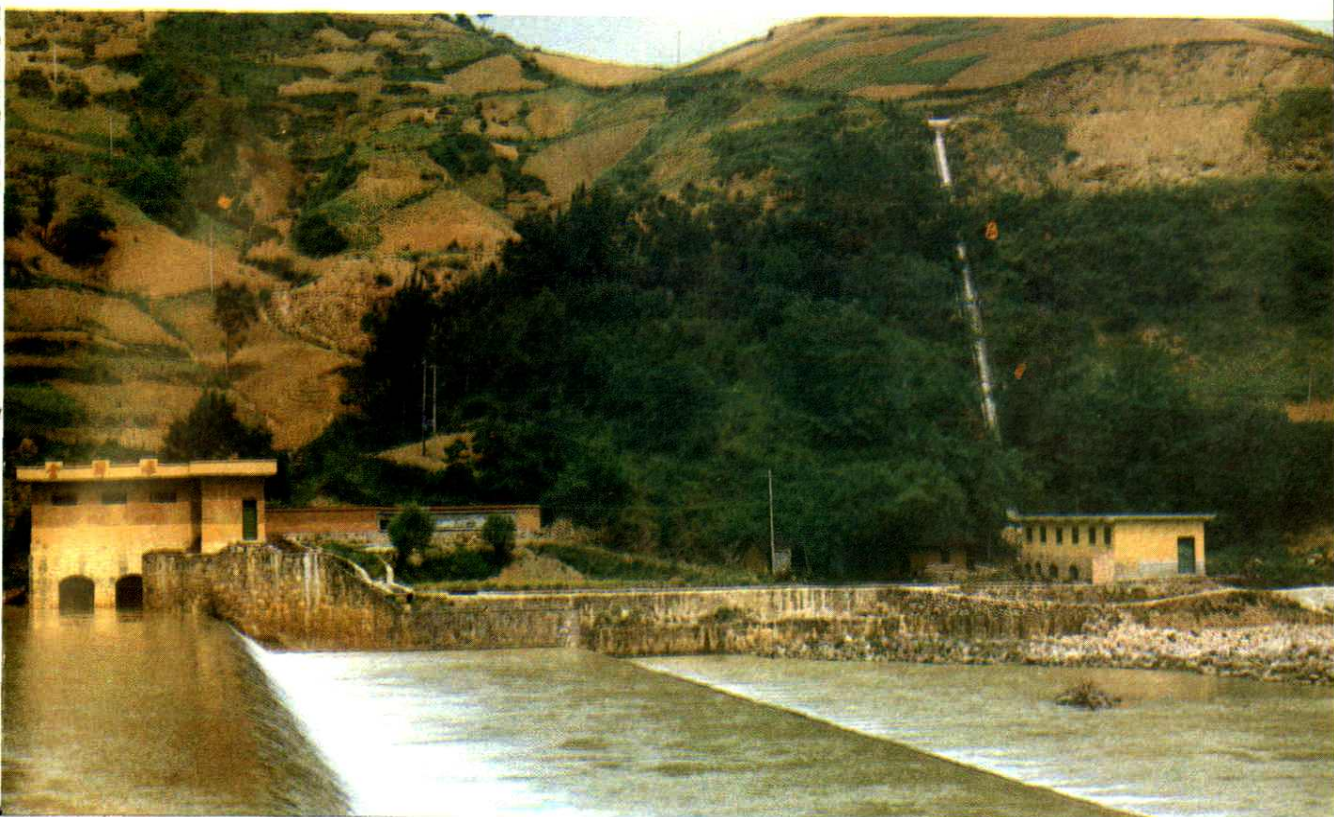
西乡堰口水轮泵站
