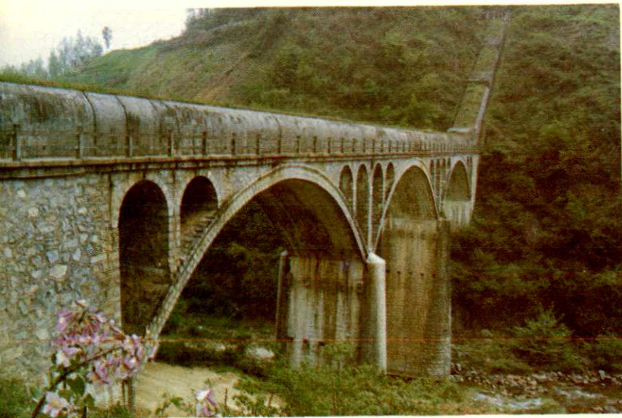
引西总干渠王河桥式倒虹
