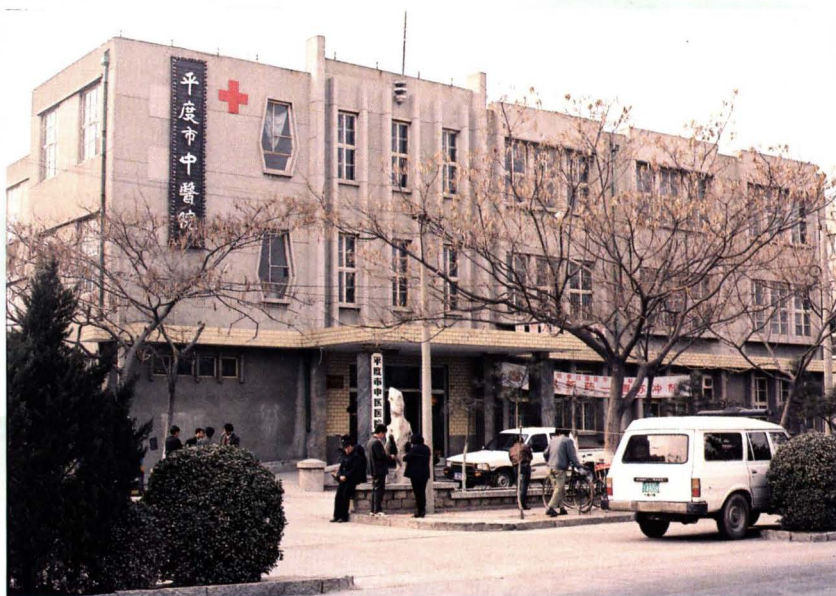
图 1-22 1997 年冬门诊楼外景
