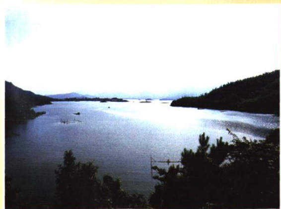
灵川县青狮潭水库，建于1958年
