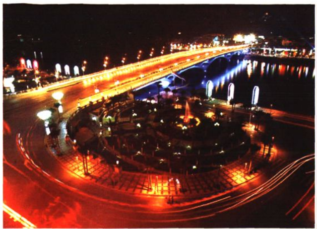
新解放桥于1999年动工，桥长284米，5孔，桥宽45米， 于2001年9月竣工
