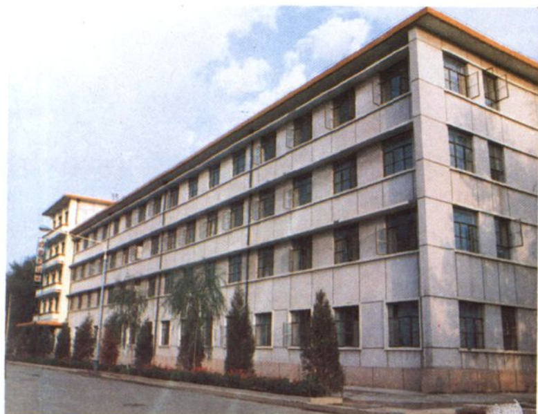
一九八四年建成的工厂招待所大楼
