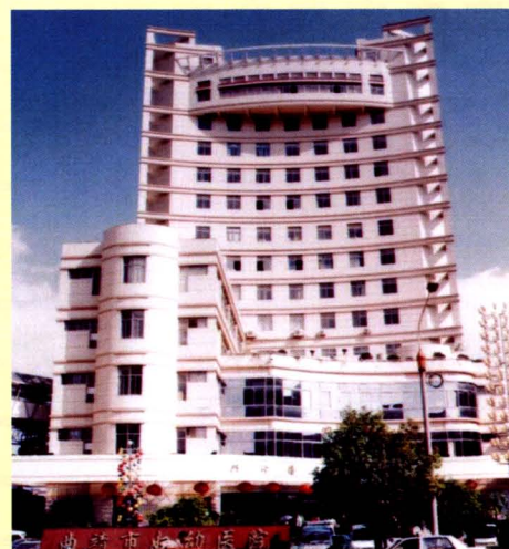
2004年6月，医院门诊大楼落成
