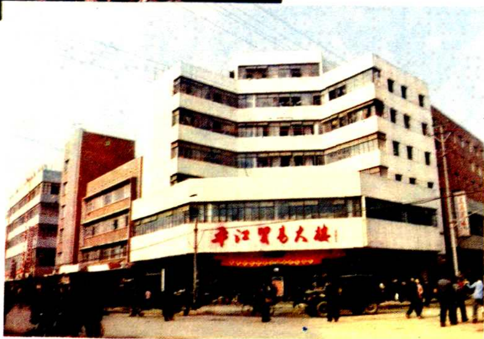
1988年建成的 平江贸易大楼
