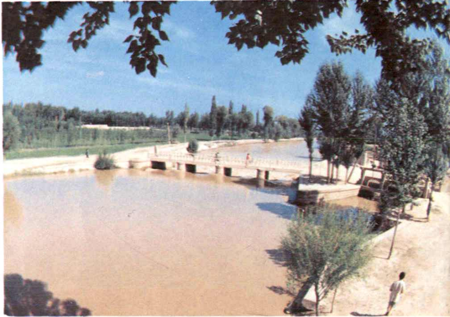
老民生渠进水闸及民生桥
