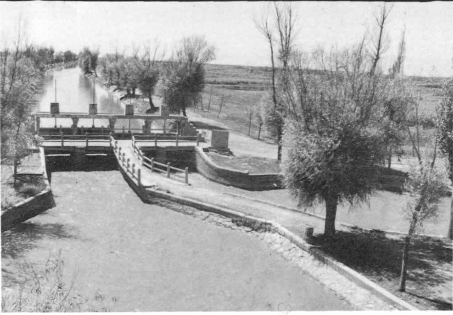
蔡家桥闸 (昌润渠与滂渠分水闸)
