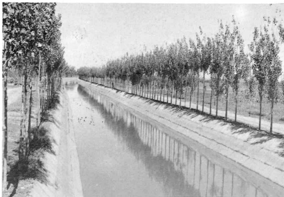
官泗渠防渗砌护渠段
