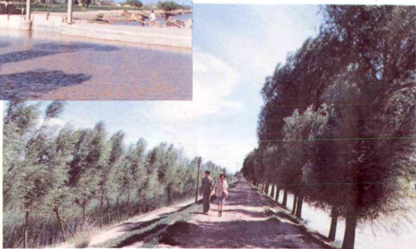
整修后的标准渠堤
