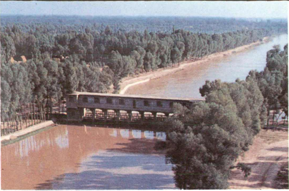
龙门桥九孔进水闸
