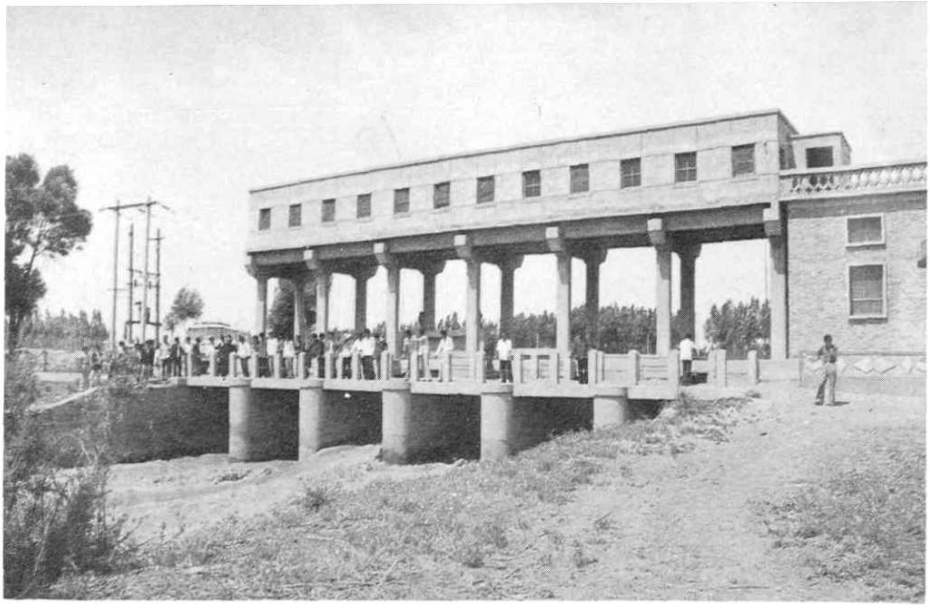
河西总干渠唐三闸（惠农渠引水闸）
