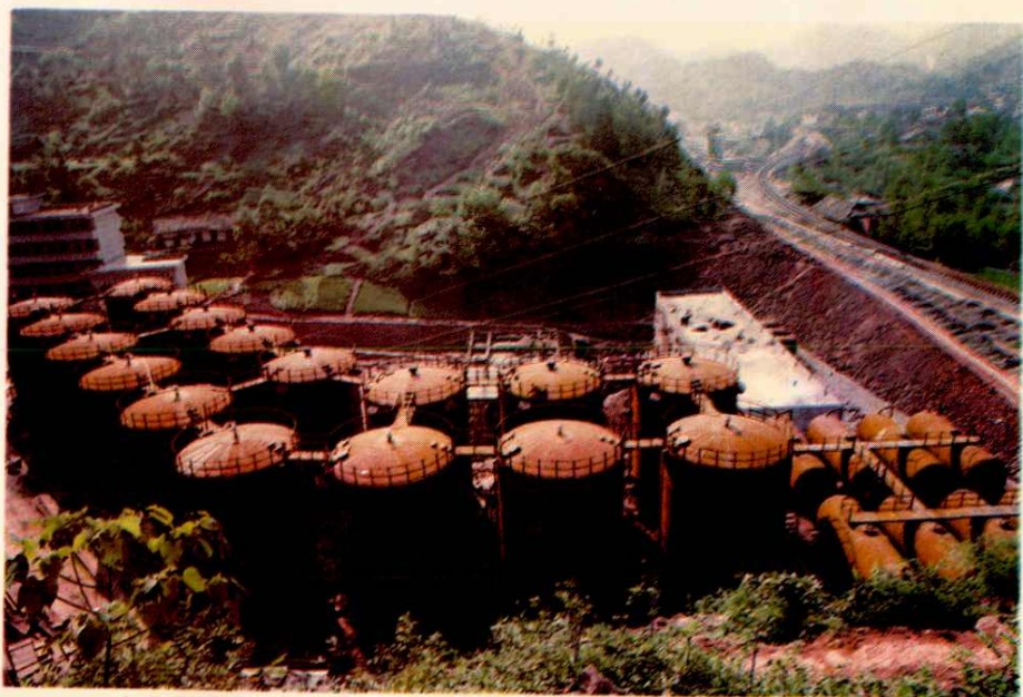
南江县罗坝石油中转库
