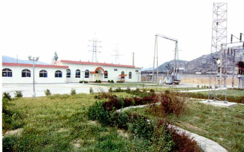
花园式的南关二〇千伏变电站
