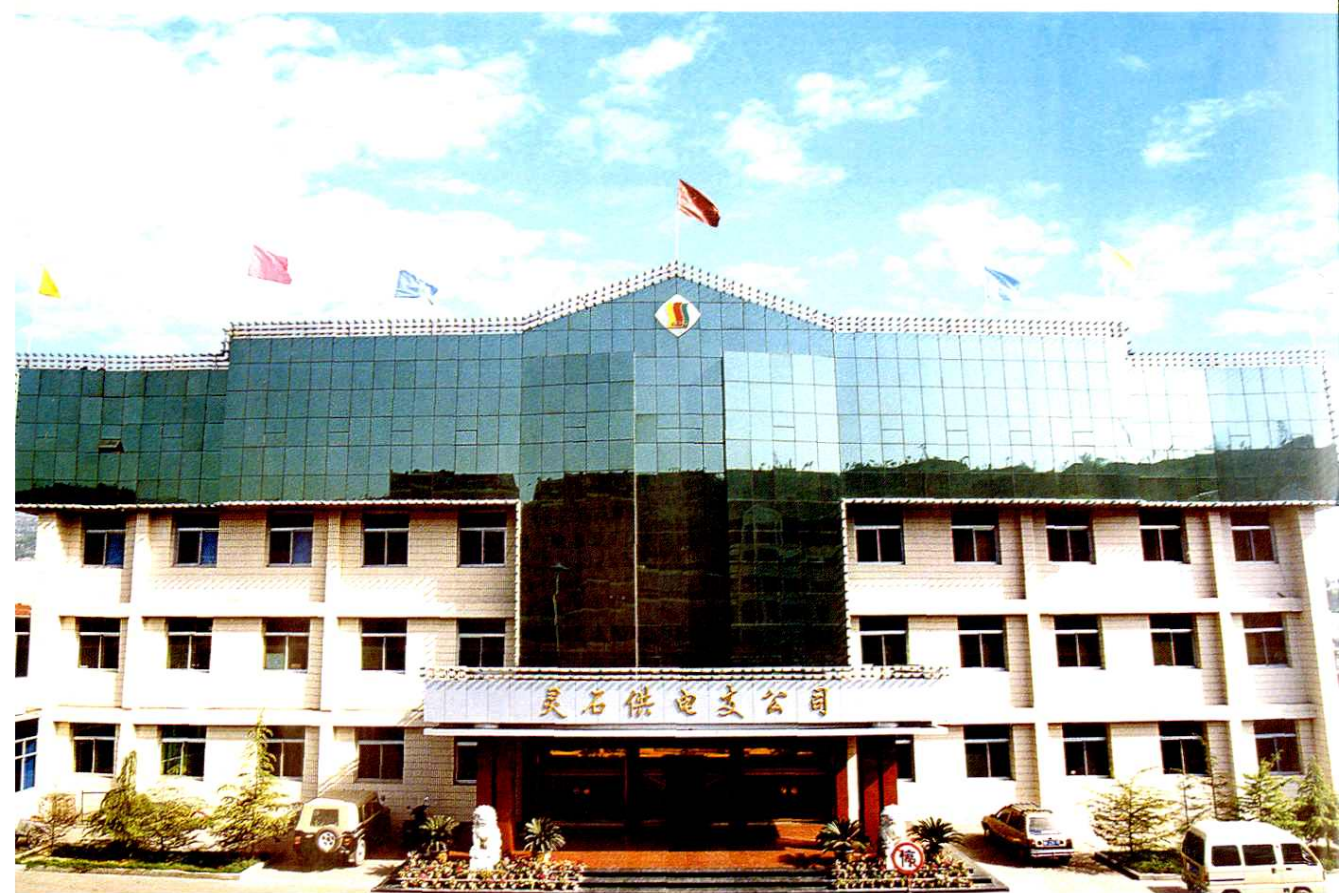
灵石供电支公司办公大楼
