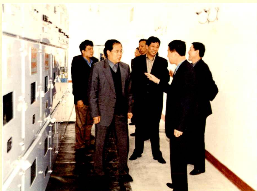
2003年4月9日,灵石县人民政府县长温毓诚(左二)视察仁义110千伏变电站。
