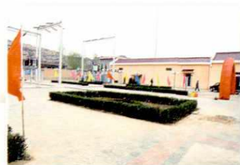
仁义 110 千伏变电站
