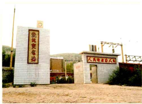
段纯 35 千伏变电站
