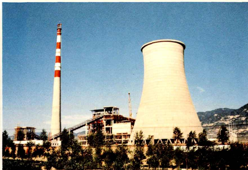
山西天石电力有限公司全貌
