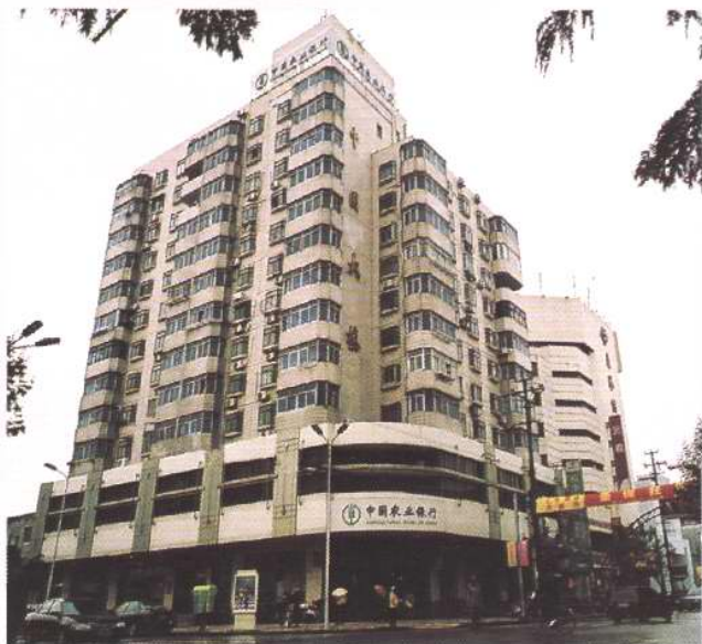
80年代惠南镇第一座高层建筑——农业银行大楼。
