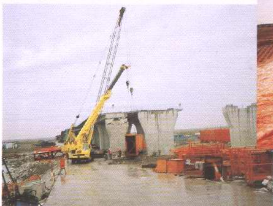
2004年的东海大桥工地。
