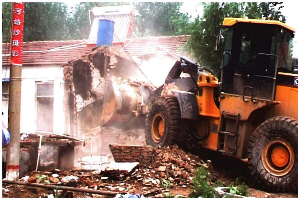
2010年4月，拆除违法占地建房
