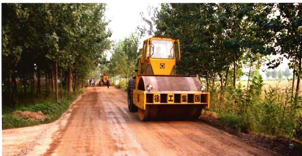
2009年9月9日，马楼乡土地开发整理中修路
