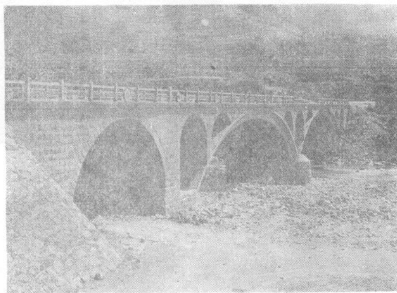
专用公路——拉克矿山大桥
