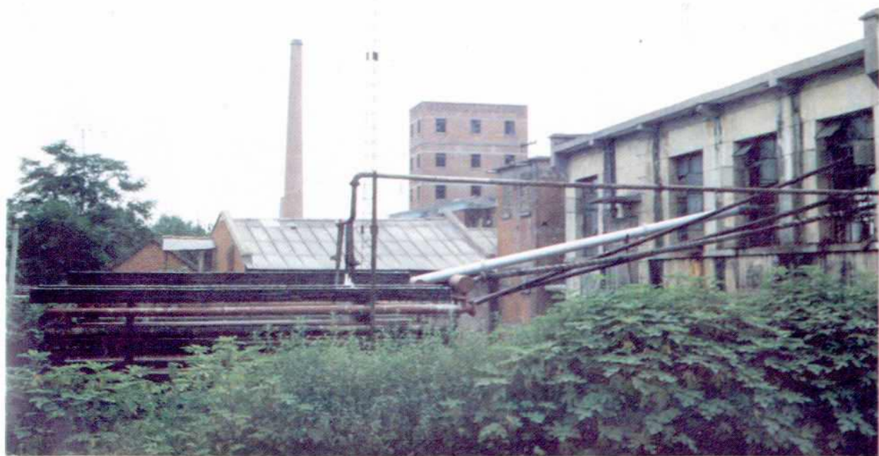
唐河县油厂浸出油车间
