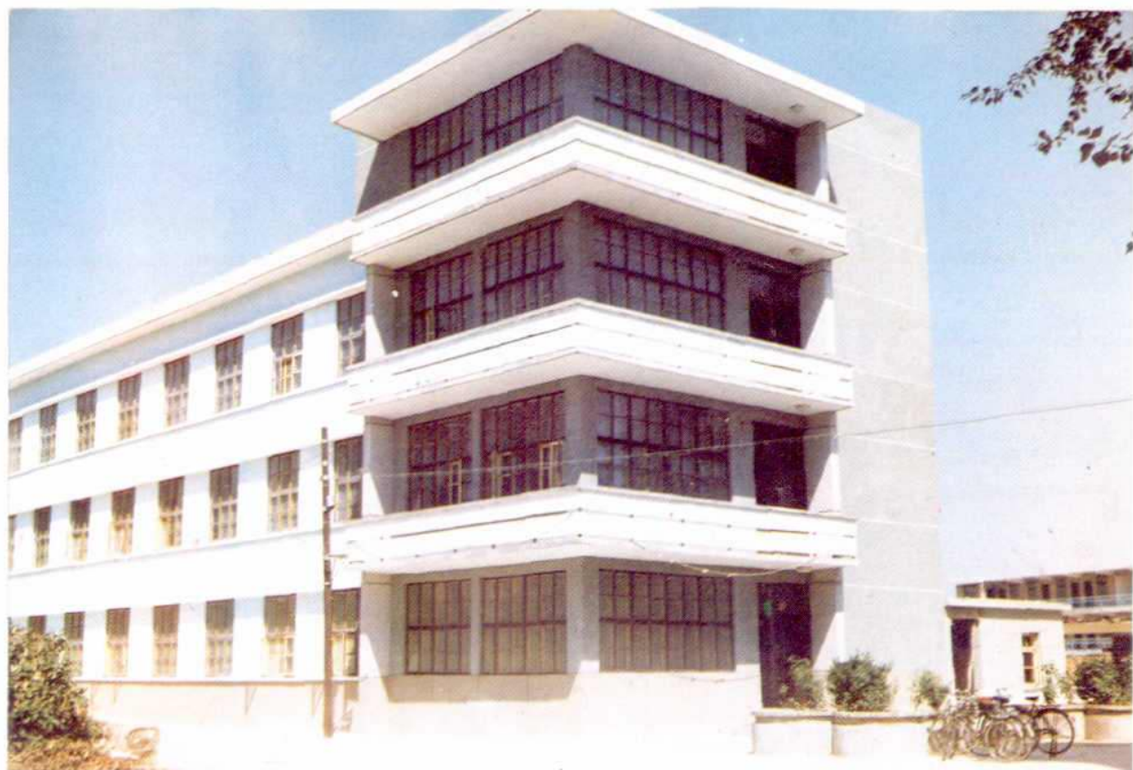
地区粮食局二号办公楼
