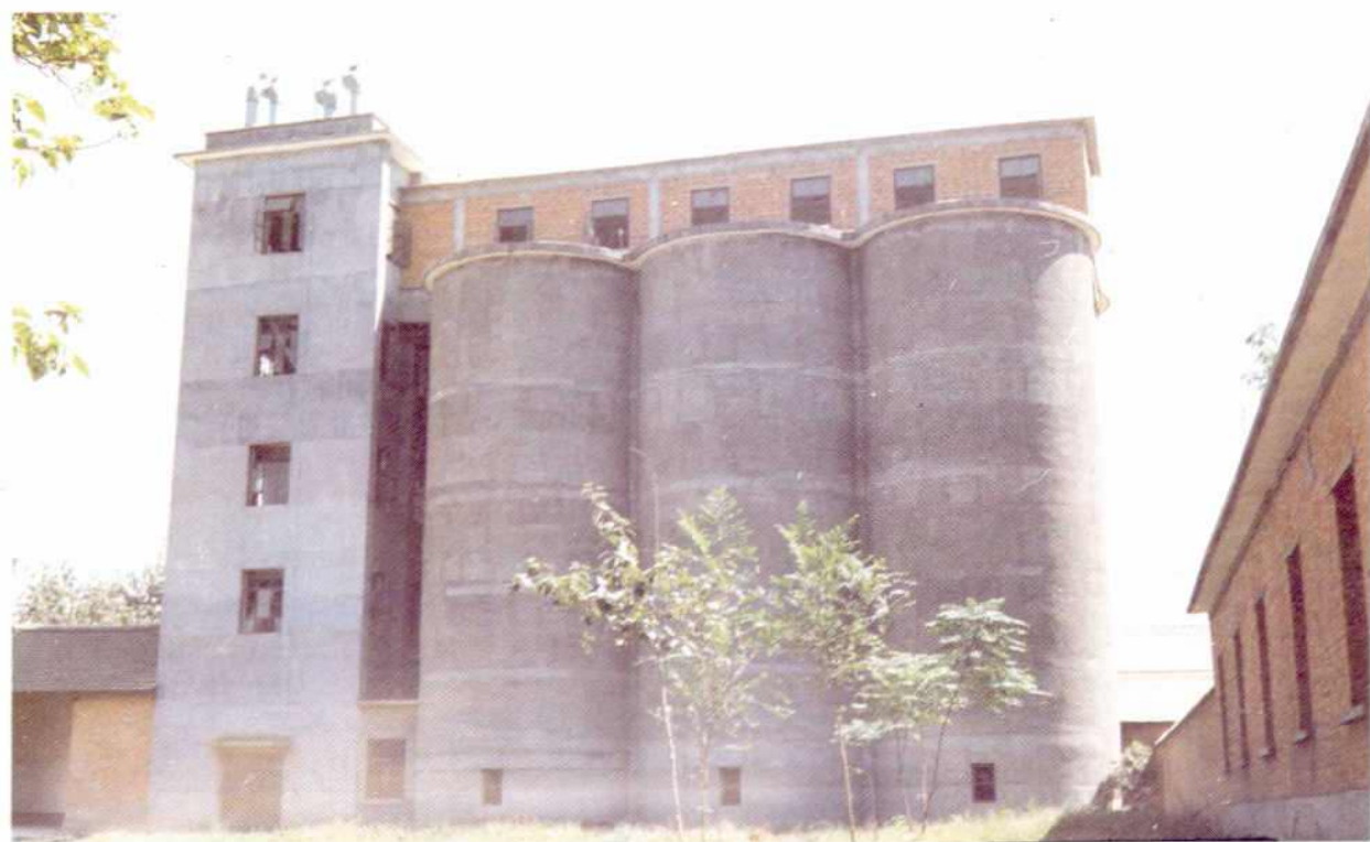
南阳面粉厂立筒仓
