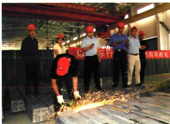
岔枕端头钢筋切割
