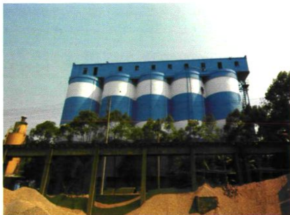
粉刷一新的水泥罐
