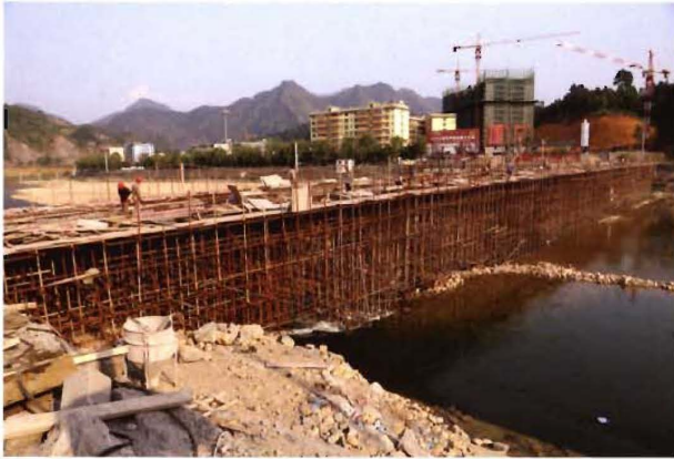
建设中的县城都柳江大桥（2013年摄）
