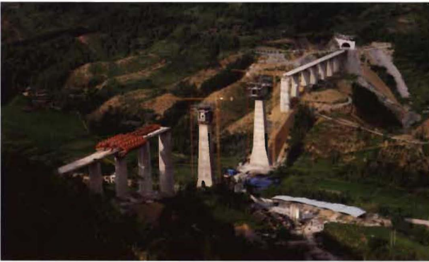
建设中的贵广快速铁路交梨莫家寨大桥（2011年摄）
