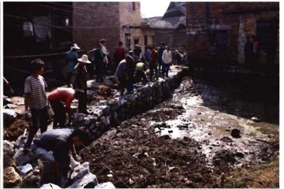
村寨道路建设（2012年摄）
