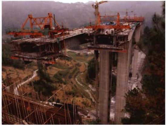
建设中的厦蓉高速公路交梨河大桥（2011年摄）
