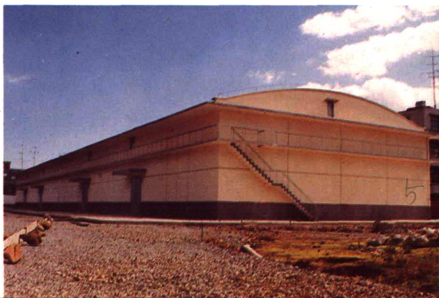
新式拱顶仓（第二直 属库）。
