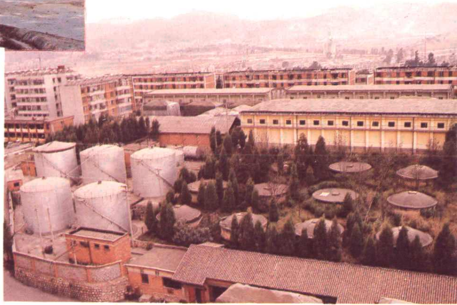
钢板油罐及砵油罐 (第三直属库)。
