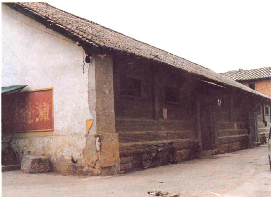
西仓坡老二库。
