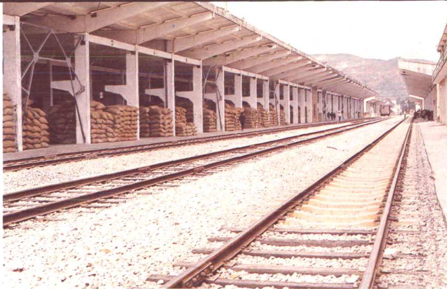
第四直属库专用铁路 及站台。
