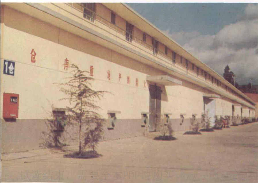
地槽通风新型拱板准 温仓（第四直属库）。
