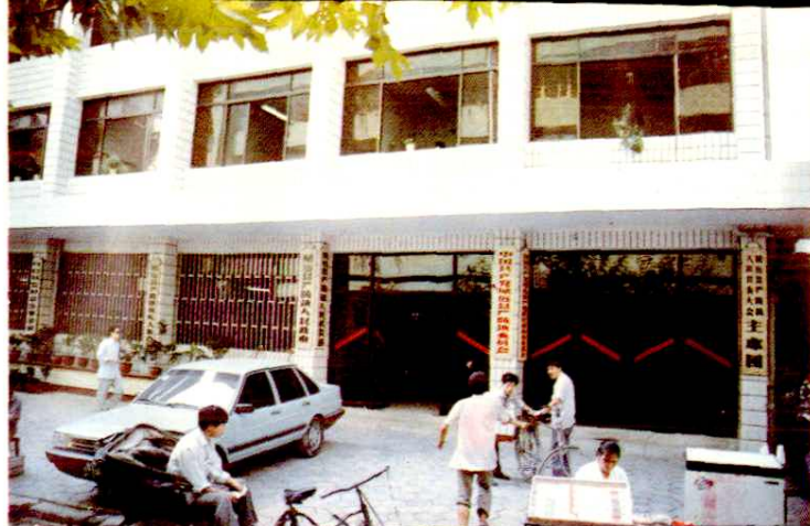
严陵镇党政机关办公楼
