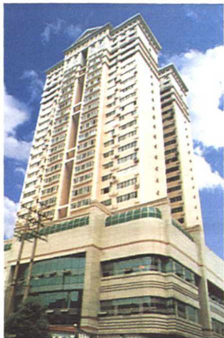
▲省建设厅综合培训楼
