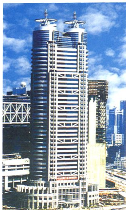
▲上海中保大厦安装工程
