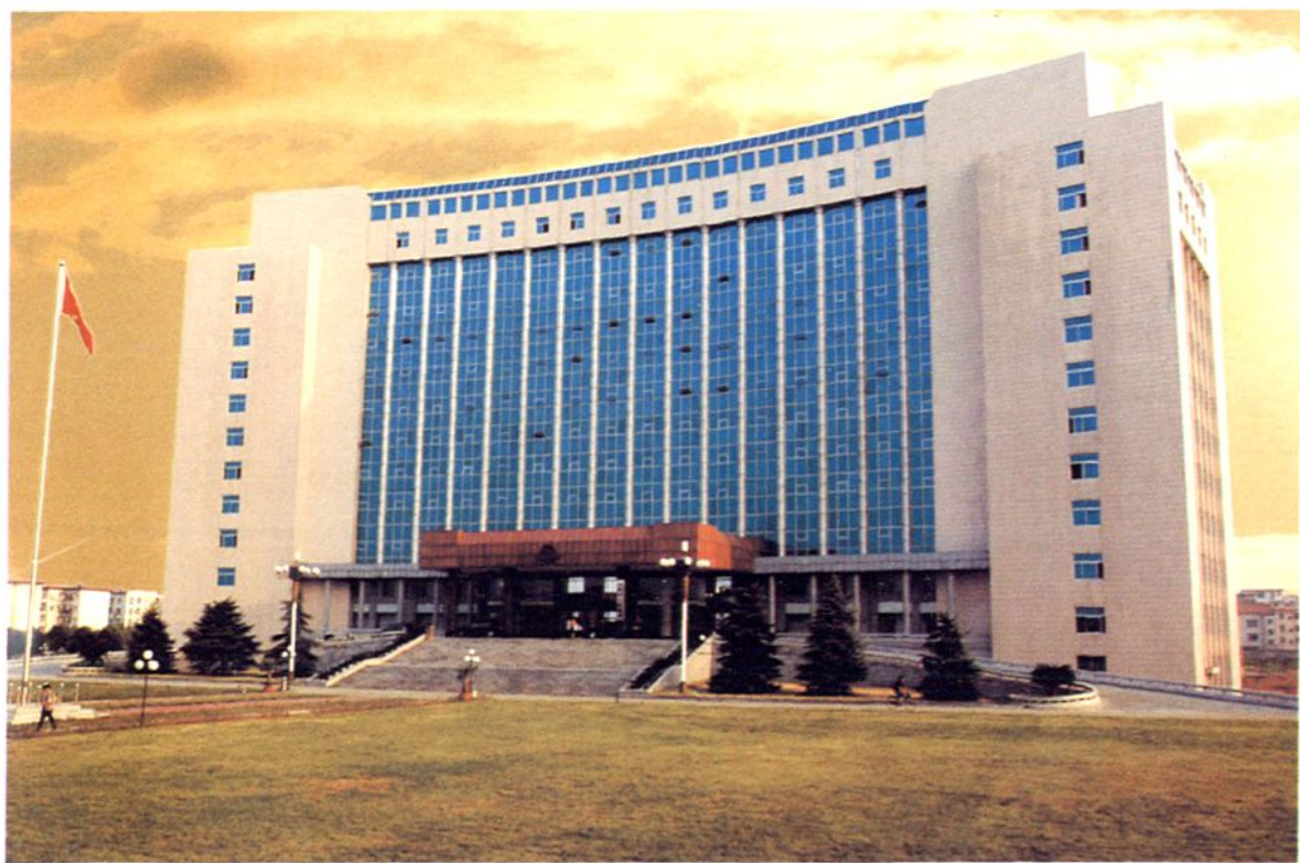
▲ 岳阳市政府办公楼
