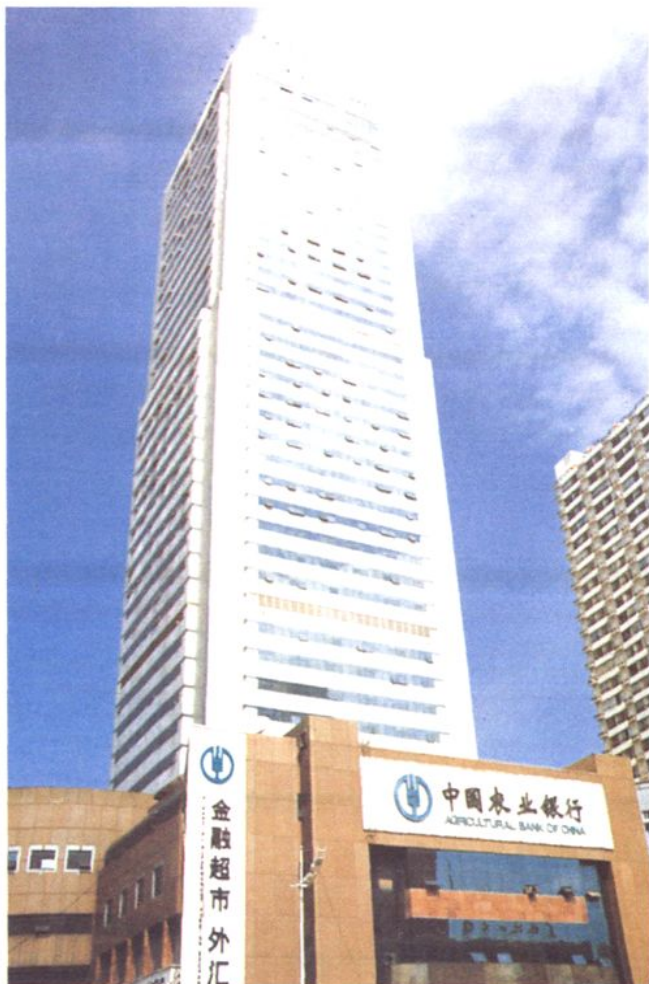
▲湖南国际贸易金融中心(全国建筑业新技术应 用示范工程金牌奖)
