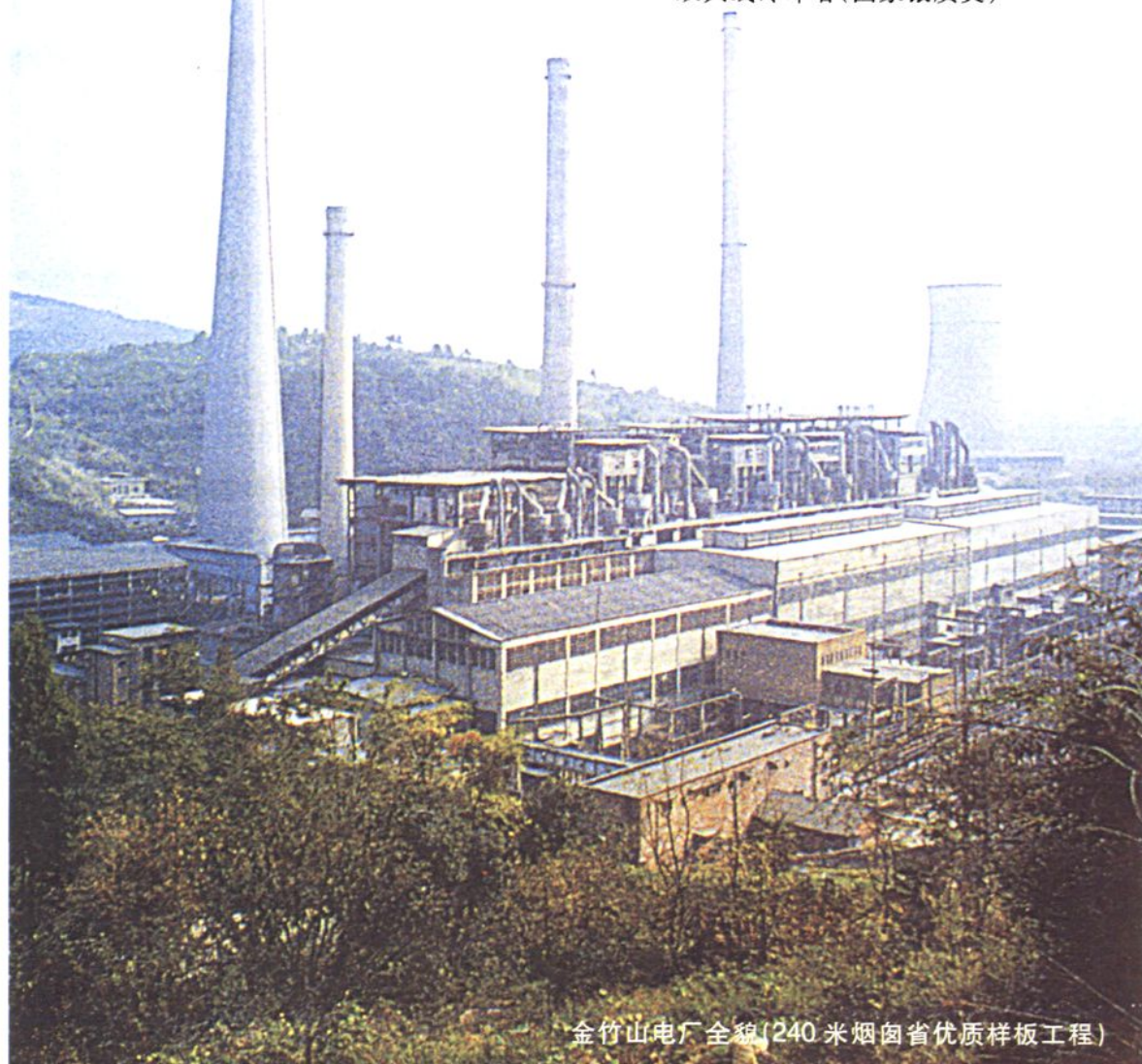
金竹山电厂 110 米高横流式 双曲线冷却塔(国家银质奖)
