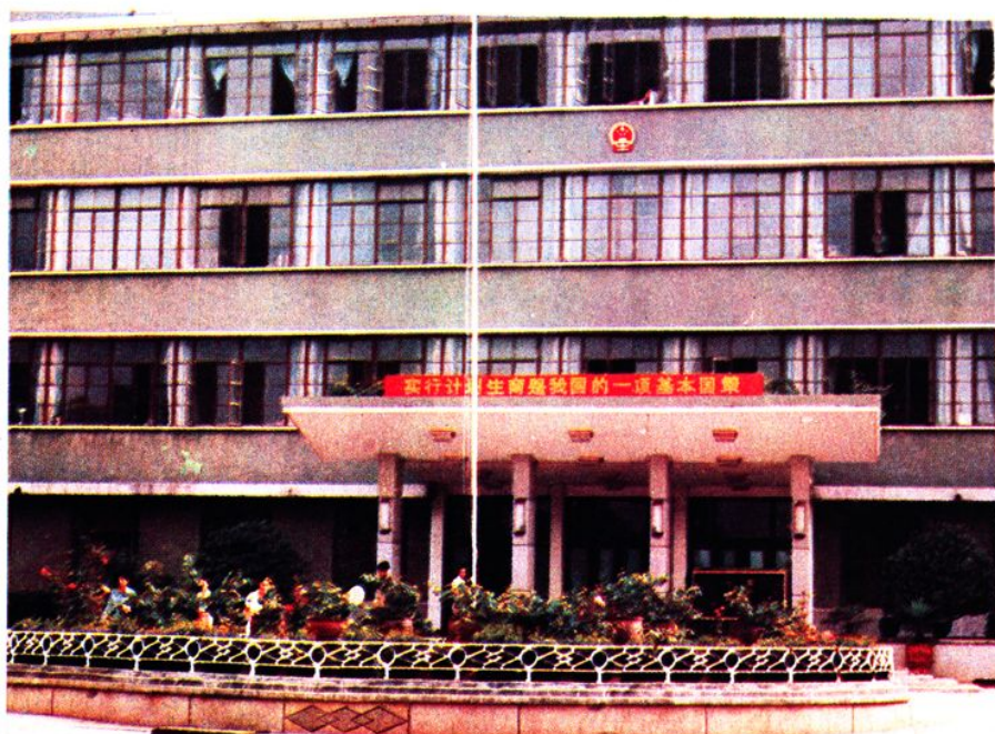
唐河县人民政府办公大楼
