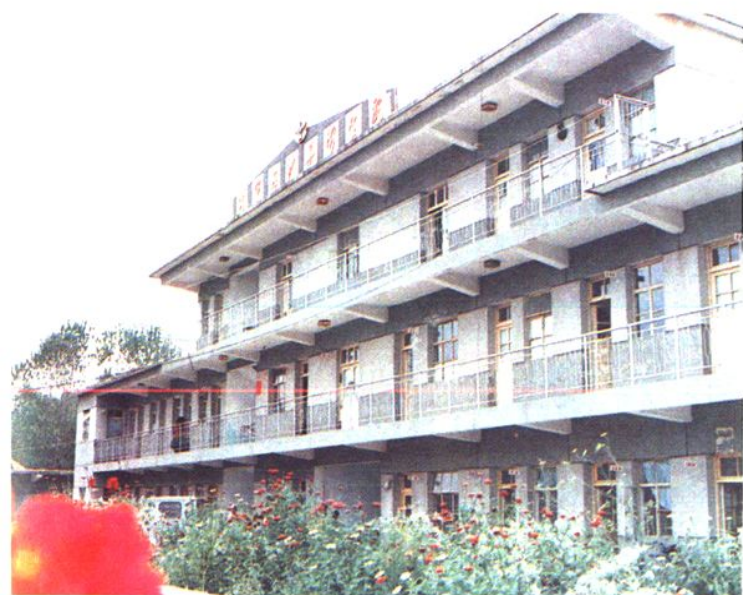
睢宁县沙集镇卫生院门诊楼
