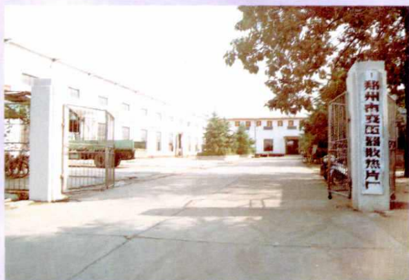
十里铺村变压器散热片厂
