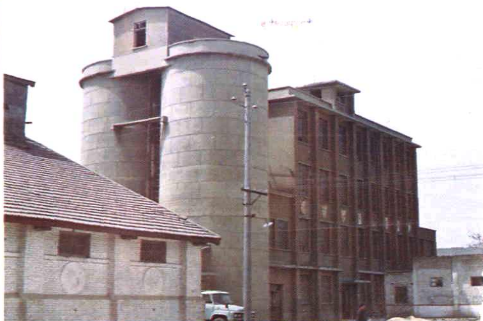
安阳市面粉厂粉车间
