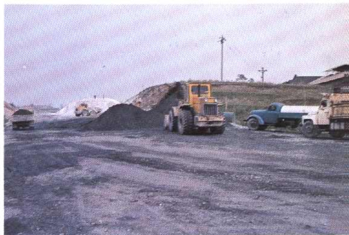
正在建设中的成渝公路
