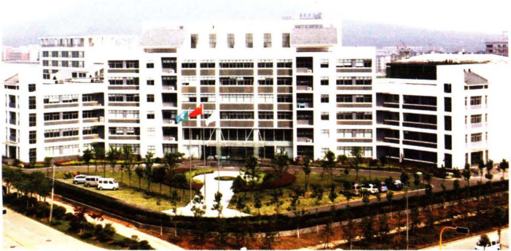
● 红枫路校区教学大楼
