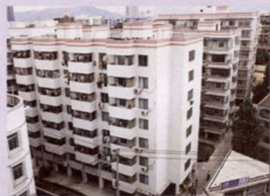
新建的茶园新村职工宿舍。已实现职工人均一套住房
