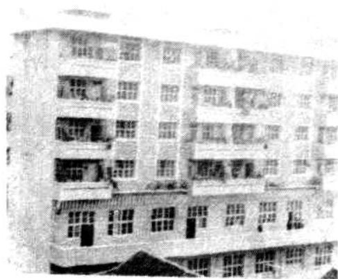
五金公司办公楼
