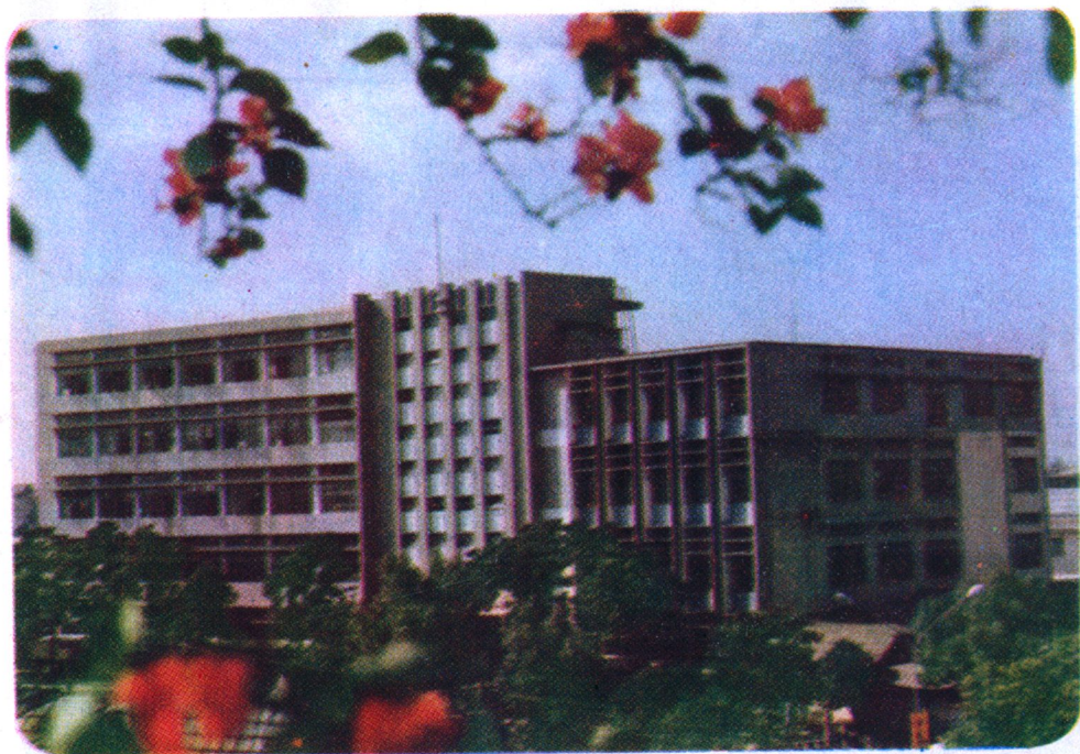
广东省电气控制设备厂外貌
