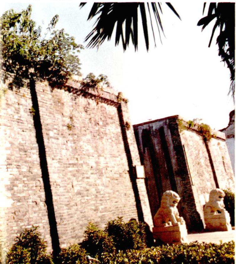
云间第一楼楼基
