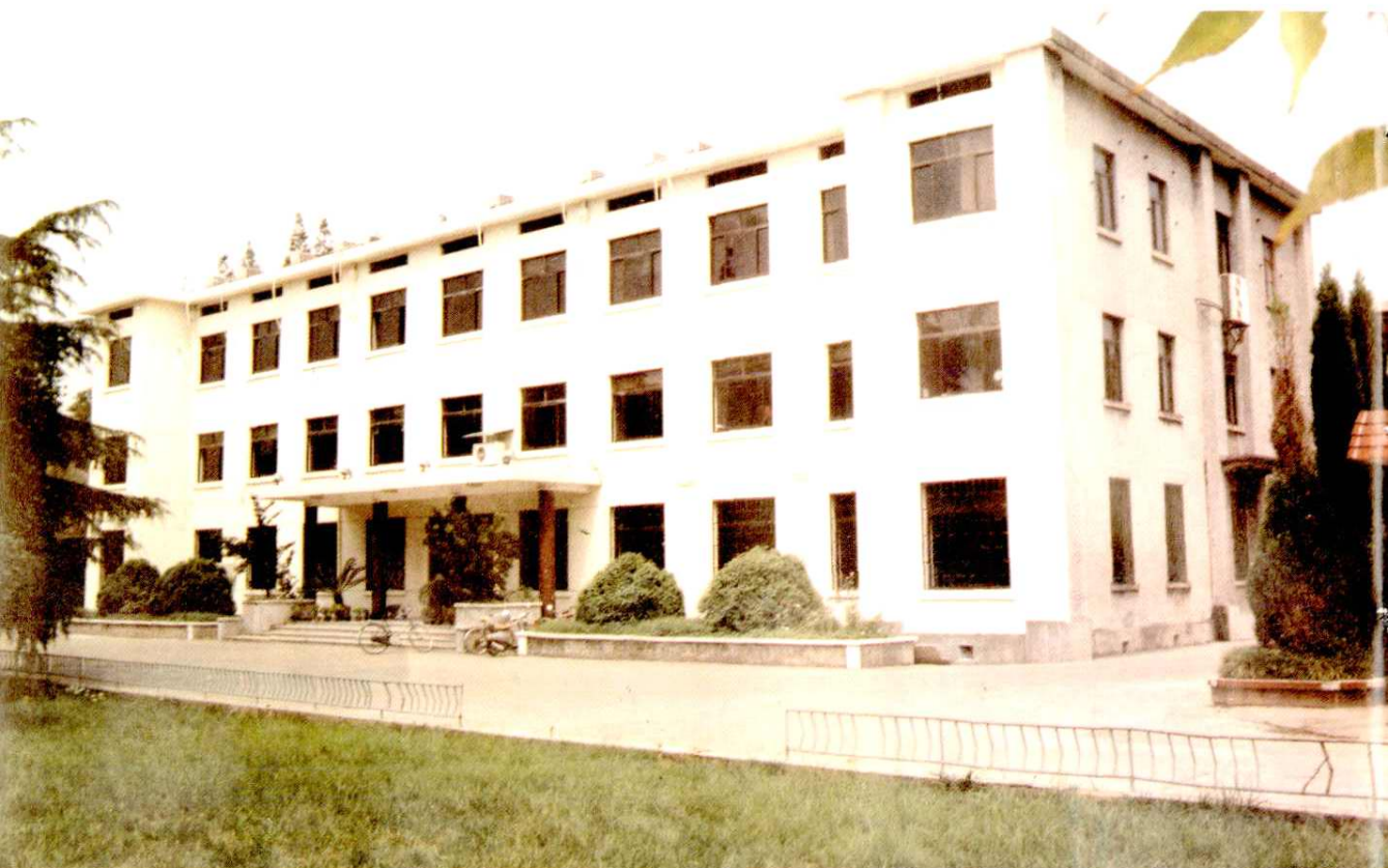
县政府办公大楼
