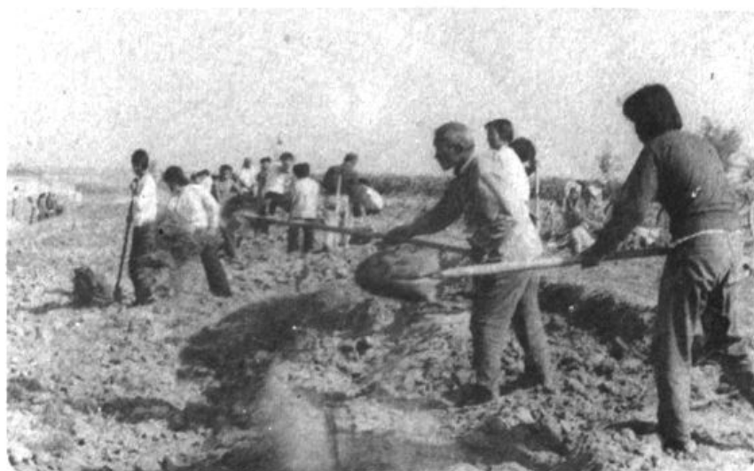
建勤民工修筑路基
