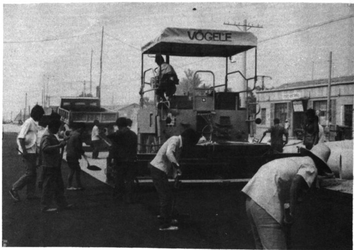
使用拌和楼、摊铺机施工
