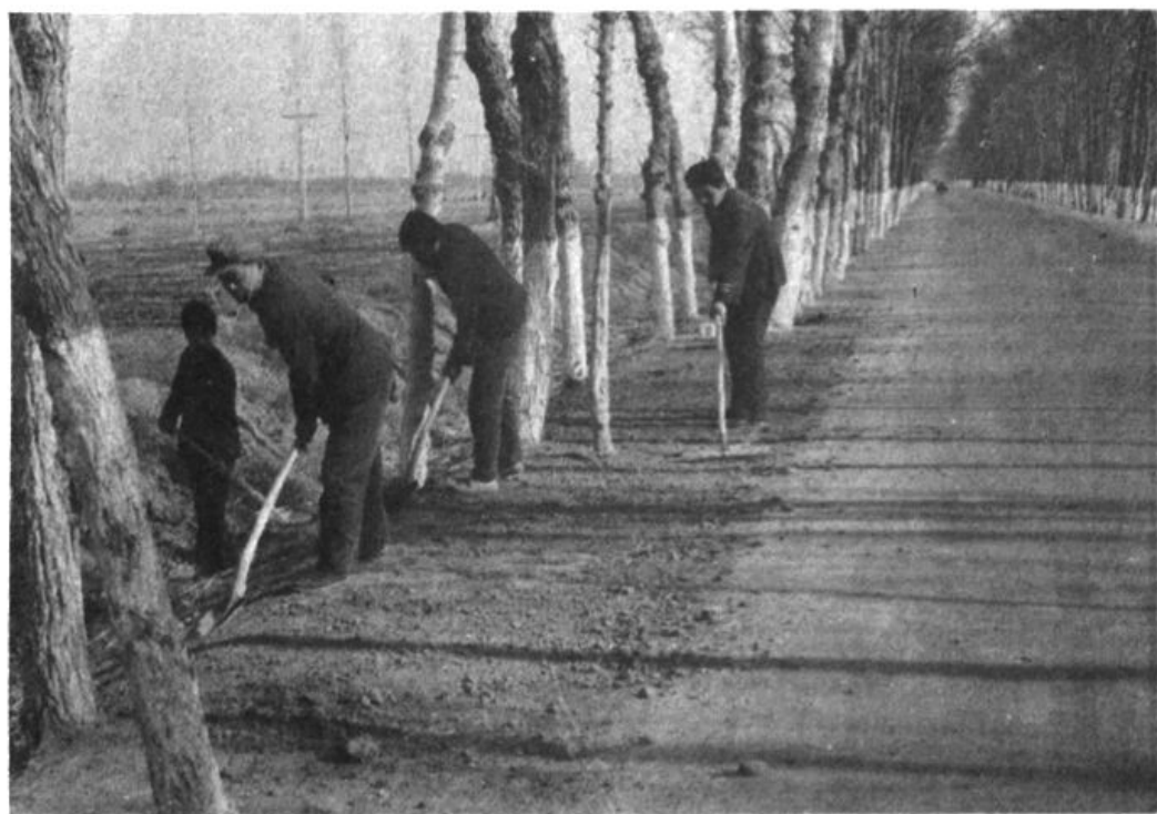
养路工修整路肩
