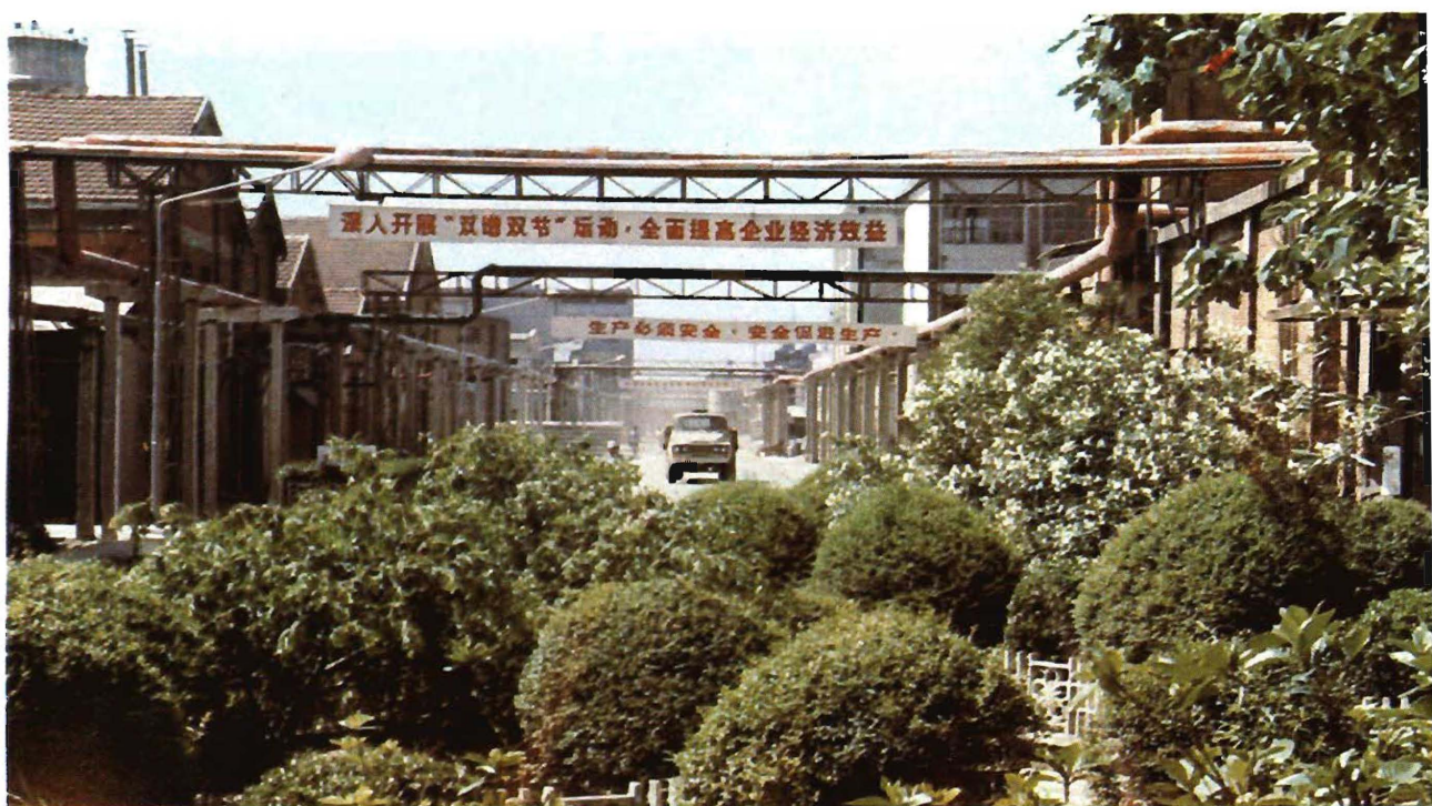
昆山化工厂厂区
