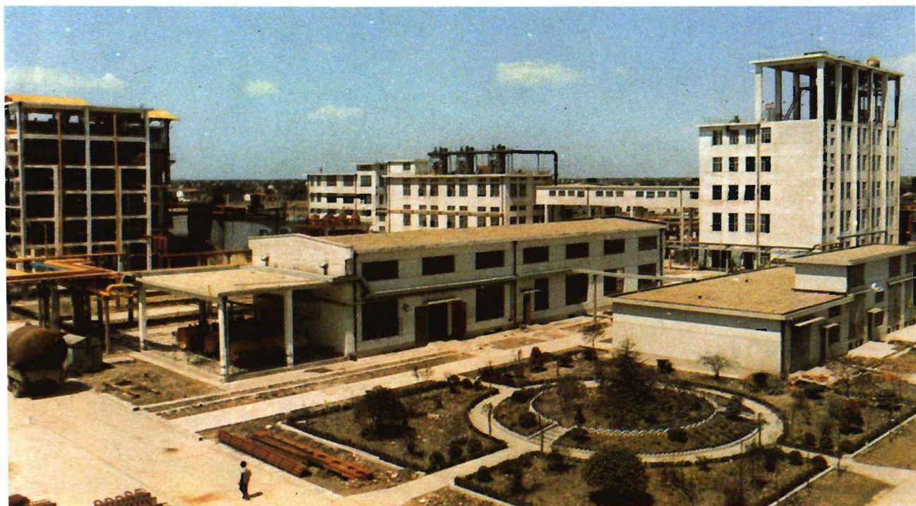
昆山化肥厂纯碱工程
