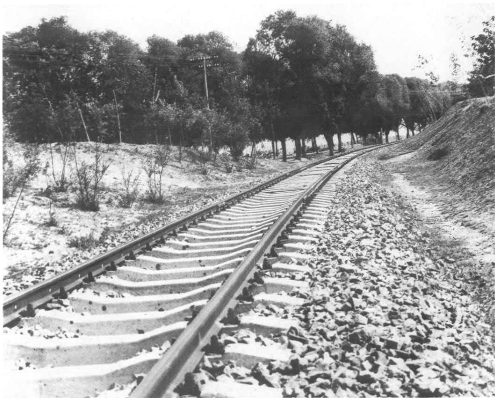
兰（考）一坝（东坝头）铁路
