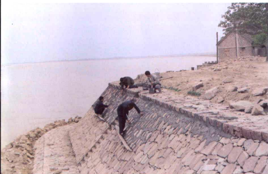
东险工 28 坝改建施工
