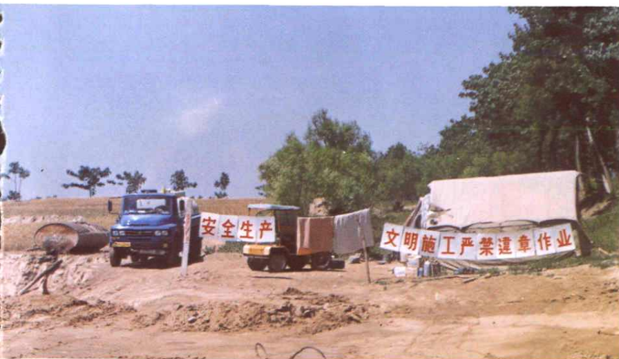
南北庄压渗工程施工现场
