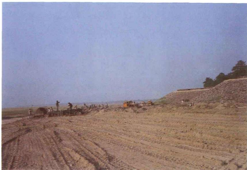
四明堂截渗施工现场
