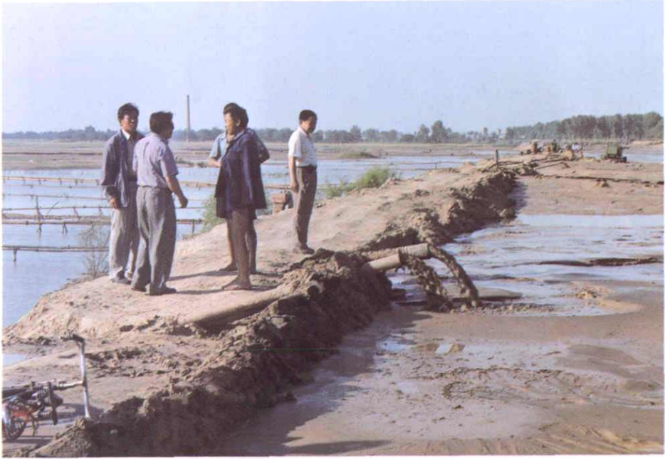
南北庄淤临施工现场
