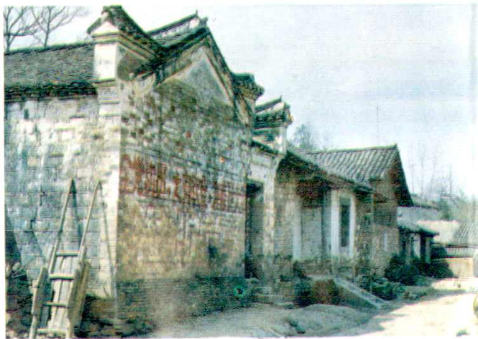
《江汉日报》印刷厂旧址——随县双河艾家老湾。
