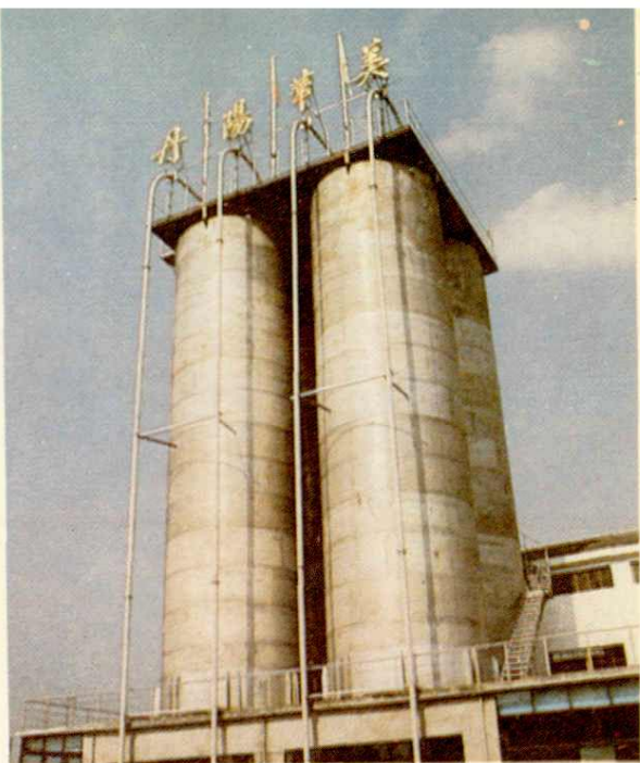
丹阳市华美塑料有限公司厂区一角
