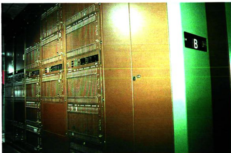
长途电话、市内电话合一的 程控数字自动交换机
