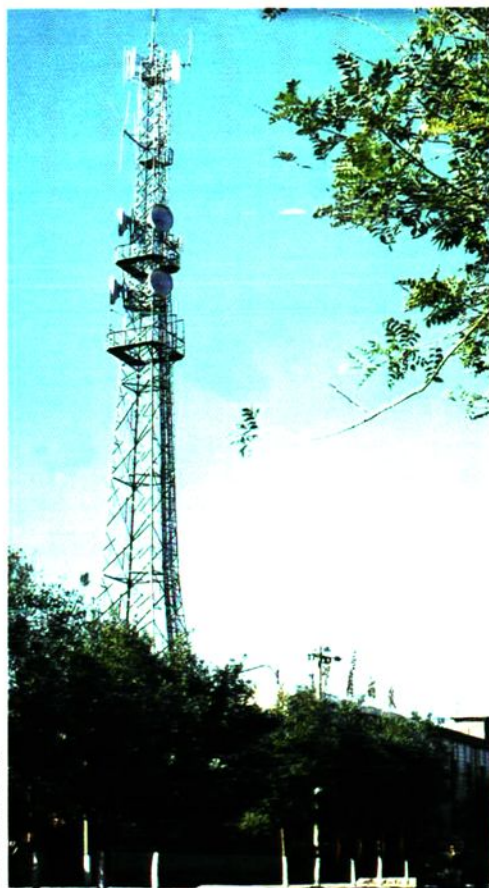
微波天线铁塔
